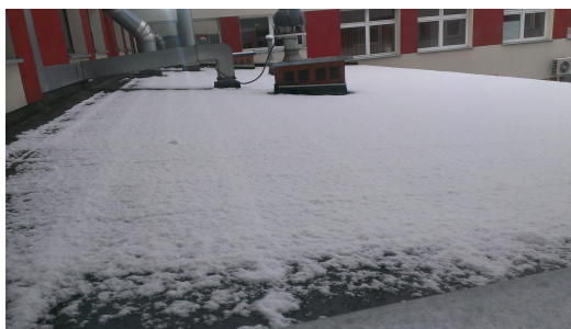
fot 6. Widok sąsiadującego budynku na którym projektowana jest centrala
