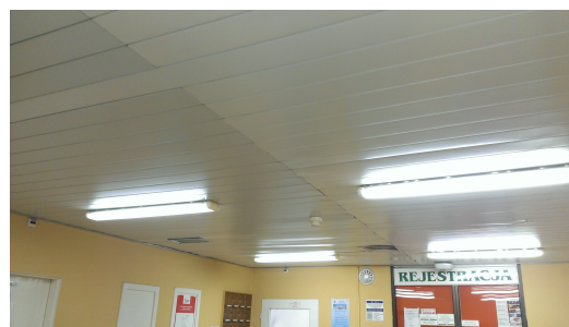
fot 3. Widok sufitu podwieszanego
