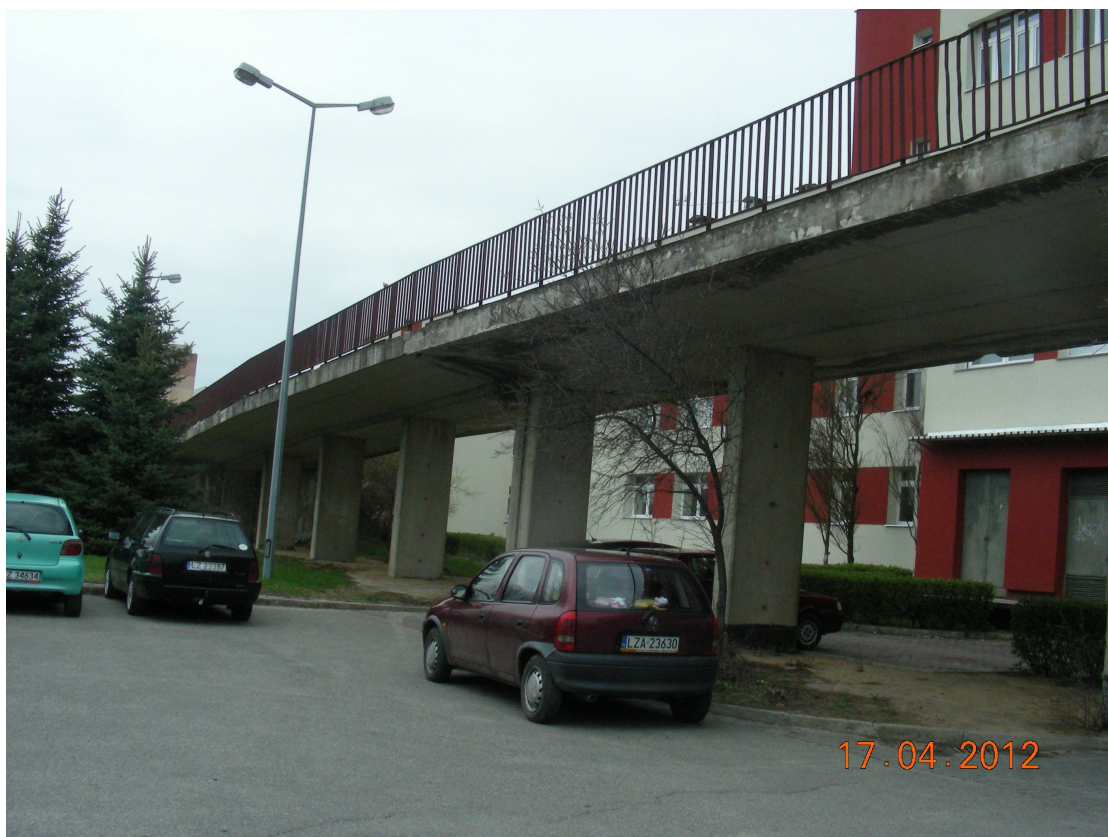
Fot. 4 Widok ogólny estakady '2012.
