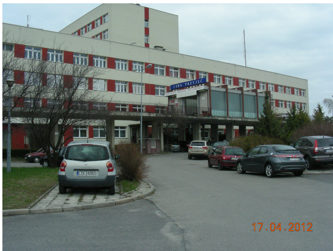
Fot. 2 Widok ogólny estakady od strony południowej '2012.
