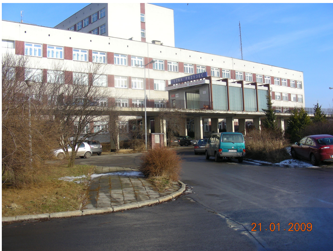
Fot. 1 Widok ogólny estakady od strony południowej '2009.
