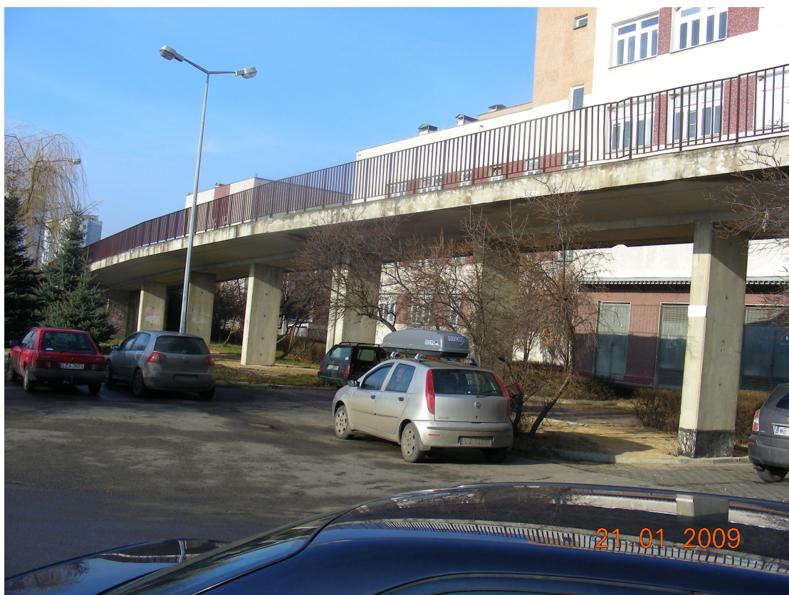
Fot. 3 Widok ogólny estakady '2009.
